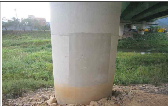
교각 하행선 P6 기둥부 정면 균열 보수
