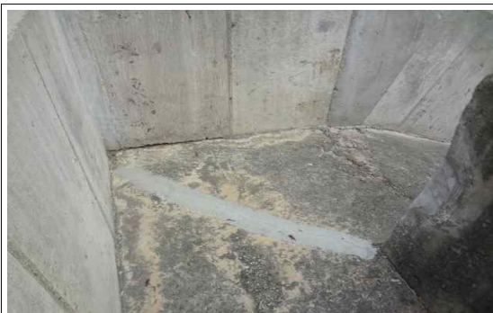
사면(시점부) STA.0+70 배수로 균열 보수
