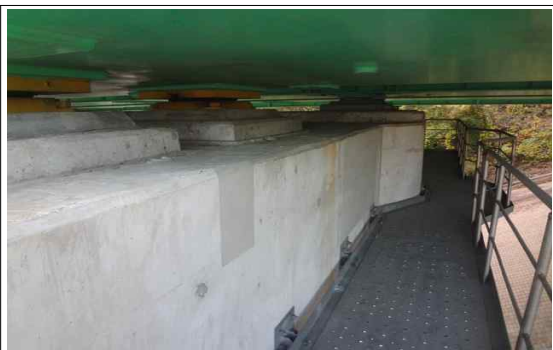
교각 상행선 P2 코핑부 배면 균열 보수
