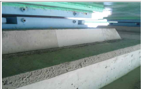
교량받침 하행선 P2-SH3 몰탈 균열 보수
