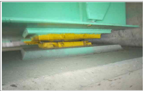
교량받침 상행선 A2-SH2
