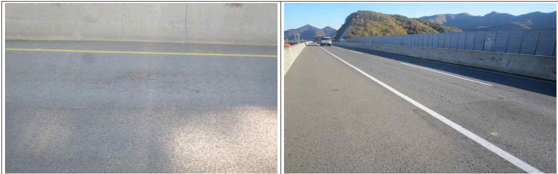
교면포장 상행선 S01 라벨링
