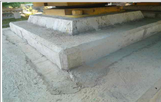
교량반침 상행선 P3-SH4 반침 들뜸 보수
