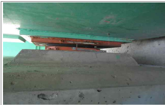
교량받침 상행선 A2-SH3
