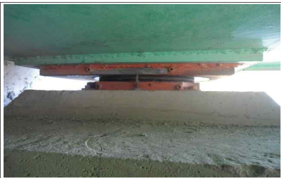
교량받침 상행선 A2-SH4
