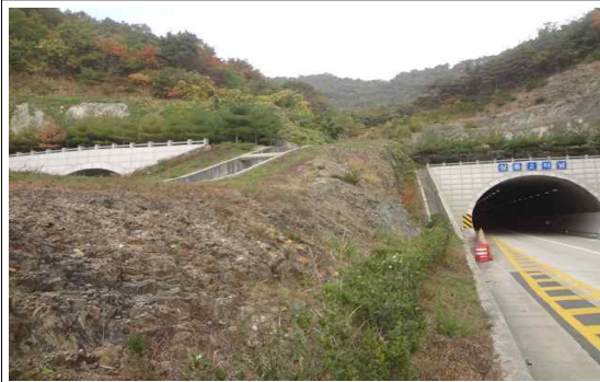
사면(시점부-상행) STA.0+ 180 1단 이완암
