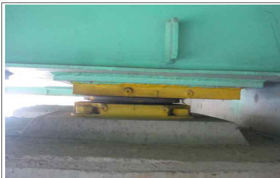
교량받침 상행선 A1-SH1
