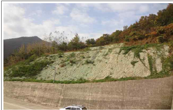
사면(시점부-하행) STA.0+ 40~90 1단 물탈격자블럭 시공
