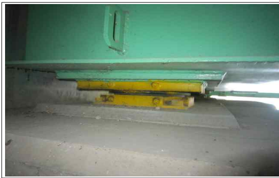
교량받침 상행선 A2-SH1
