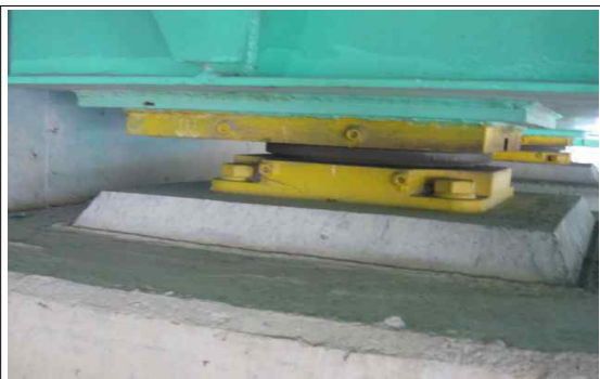
교량받침 상행선 A1-SH2
