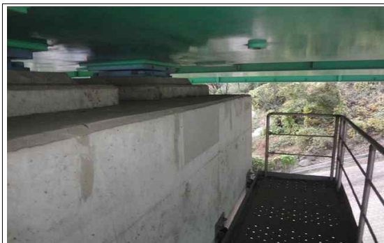
교각 상행선 P2 코핑부 배면 균열 보수
