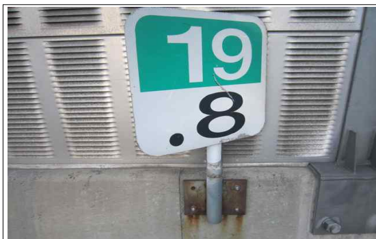
방호벽 상행선 S9 이정표 변형 및 나사폴림
